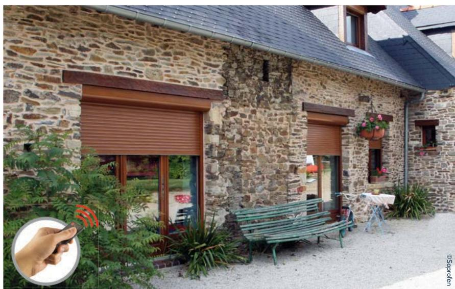
Avec 3 formes de caissons en aluminium au choix : carré, quart de rond avec face arrondie ou pan coupé à 45° et un tablier en lames aluminium de 8 à 14mm avec mousse isolante et maintenu hermétiquement dans les coulisses.
