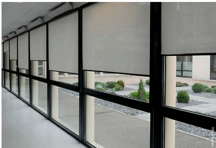
Grammage entre 300 et 500 gr/m<sup>2</sup>, le screen est constitué d'un tissage extrêmement solide d'un mélange de fibre de verre et de PVC, avec différents degrés d'ouverture possible en laize de largeur jusqu'à 320 cm
